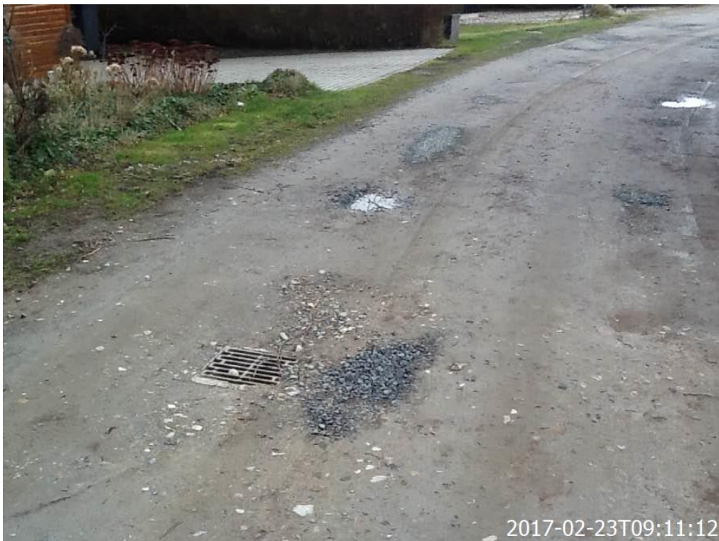
Ny nedløbsbrønd med nedsivningsanlæg ud for nr. 52 - 54
