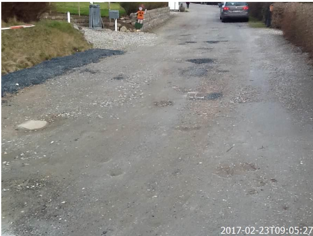
Nedløbsbrønd ved nr. 22 efter udførelse af nedsivningsanlæg.
