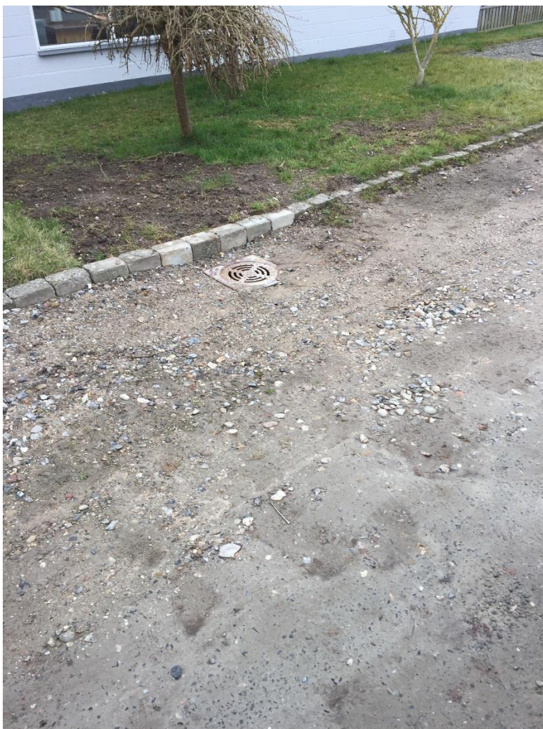
Nedløbsbrønd ved Røllikevej 30 efter udskiftning
